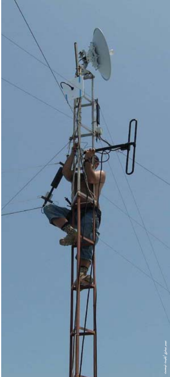
وجدان حاج أمين من فريق التدخل السريع لدعم الاتصالات والمعلوماتية في حالات الطوارئ التابع لبرنامج الأغذية العالمي (فبت) تيست) في الإمارات العربية المتحدة يعمل على تركيب هوائي موجات تردد سريع على برج الاتصالات في غينيا.
