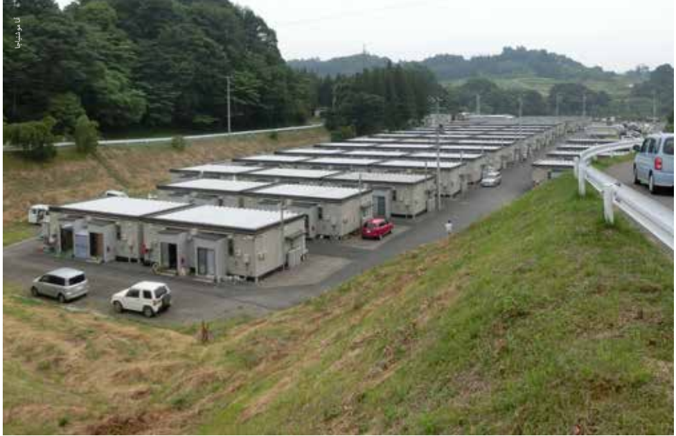
سكن مسبق الصنع ومؤقت للنازحين داخلياً في عام ٢٠١١ إثر الكارثة النووية، فوكوشيما، اليابان (التقطت الصورة عام ٢٠١٤)
