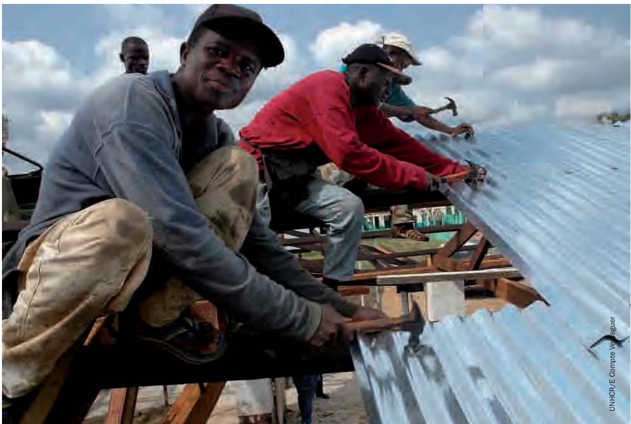
Como parte de los proyectos de empoderamiento comunitario emprendidos por ACNUR, los trabajadores construyen una escuela y transmiten sus conocimientos en la construcción a los jóvenes que regresan a su lugar de origen en Gbarlatuah, condado de Bong, Liberia.
