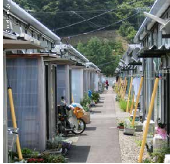
Fotografía (tomada en junio de 2014) de las viviendas temporales prefabricadas para los desplazados internos tras el desastre nuclear de 2011, prefectura de Fukushima, Japón.
