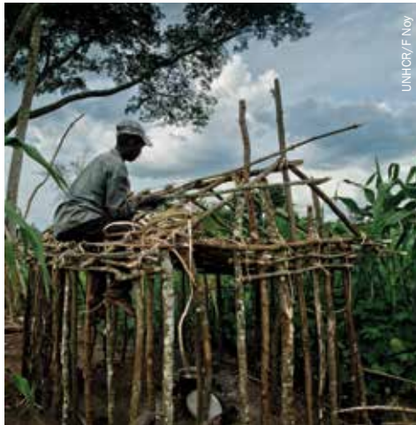
Des réfugiés congolais construisent de nouveaux abris à Rwamwanja, en Ouganda, suite à la reprise des combats dans le Nord-Kivu en 2012.
