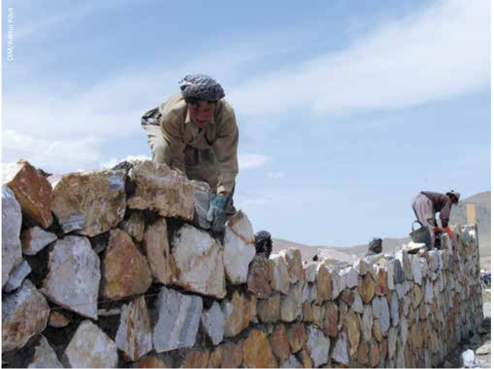
Les travaux de construction commencent sur un nouvel hôpital de Ghazni en Afghanistan.
