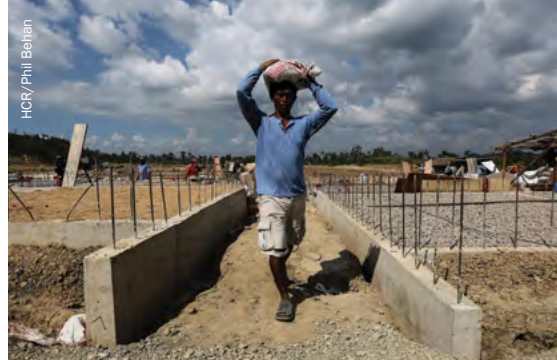
Joel Lacaba travaille sur le site de construction de son futur logement permanent à Tacloban, dans le cadre d'un programme de relèvement suite au passage du typhon Haiyan aux Philippines.
