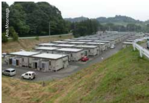
Logements temporaires en préfabriqué pour les PDI déplacées en 2011 suite à la catastrophe nucléaire, préfecture de Fukushima, Japon. (photo prise en juin 2014)
