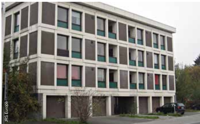
Bâtiment utilisé pour loger les familles dans des appartements privés, avec un bureau pour le responsable de dossier. Tubize, Belgique.
