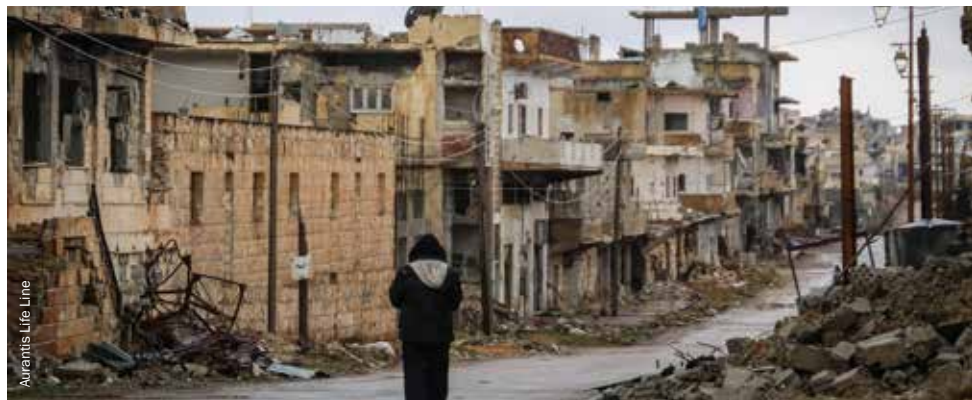
Destrucción en el barrio de Al Arbeen, centro de Dara, 2017.
