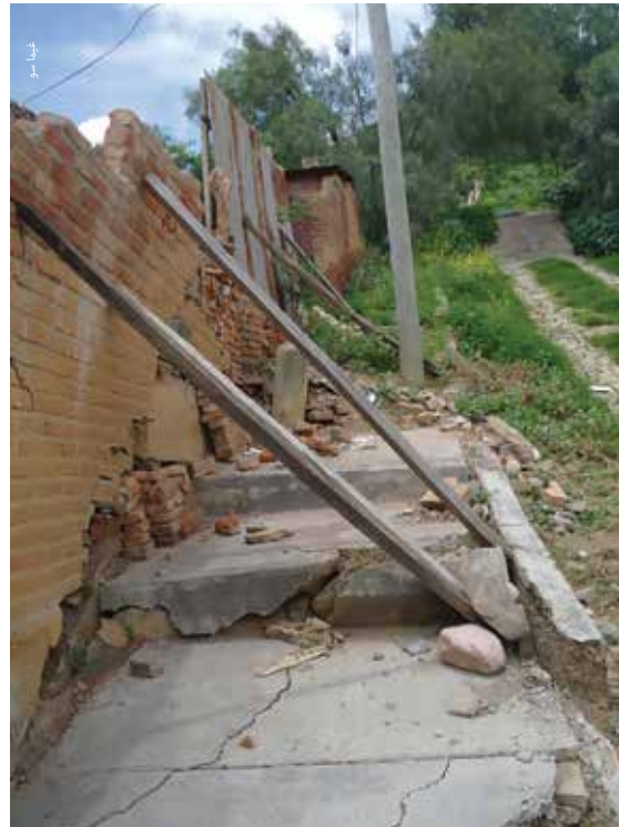
جدران مدعومة، ما بعد الانهيار الأرضي، كوتشابامبا.
