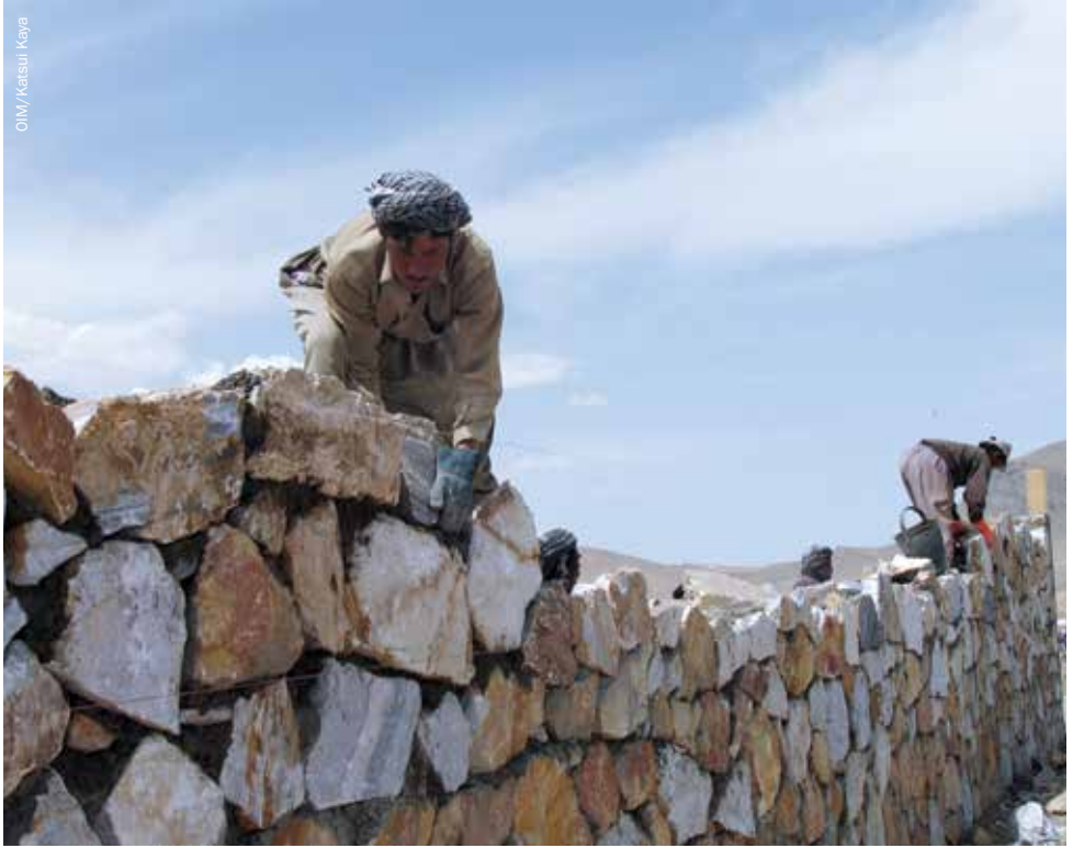
Comienzan las obras de un nuevo hospital en Ghazni, Afganistán.
