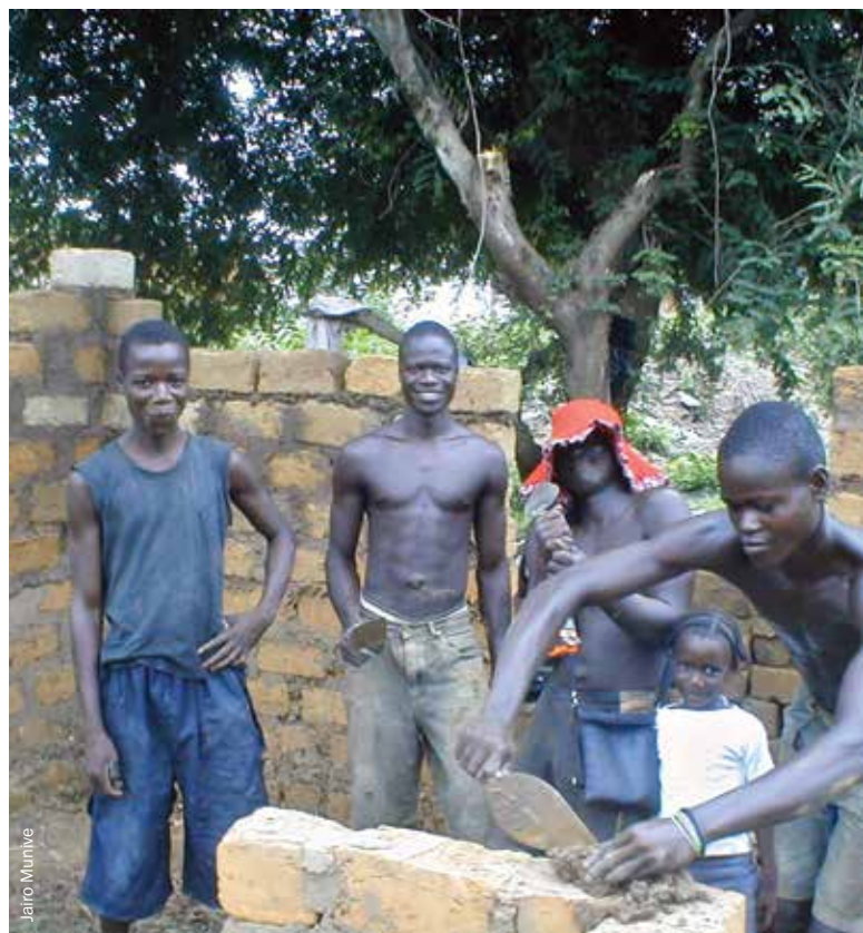
Unos excombatientes y sus familiares construyen una casa en tierras ocupadas ilegalmente en Ganta central.
