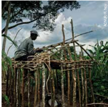
Refugiados congoleños construyen nuevos refugios en Rwamwanja, Uganda, a raíz de las nuevas oleadas de combates en Kivu del Norte en 2012.
