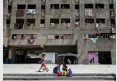
Un logement pour réfugiés syriens, qui bénéficie de l'appui de CARE International Liban. Fulvio Zanettini/Aktion Deutschland Hilft
