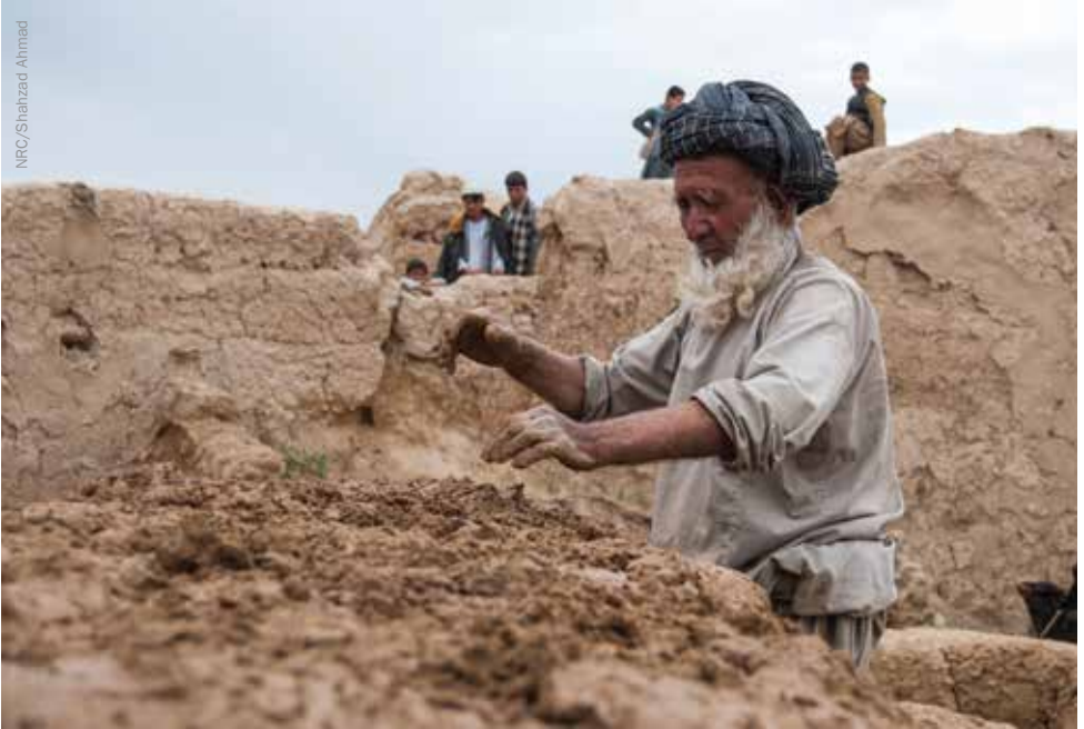
Un réfugié rapatrié reconstruit sa maison, endommagée après des années d'éloignement. Maymana, Afghanistan.
