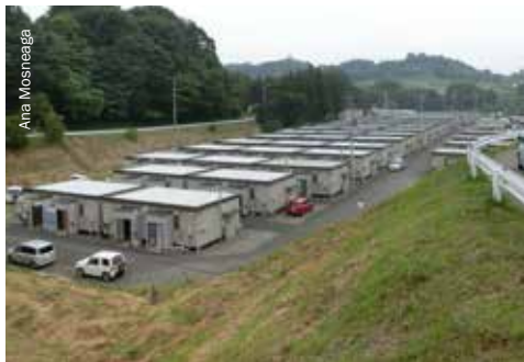
Logements temporaires en préfabriqué pour les PDI déplacées en 2011 suite à la catastrophe nucléaire, préfecture de Fukushima, Japon. (photo prise en juin 2014)
