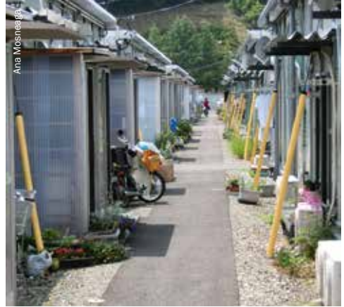
Gros plan (pris en juin 2014) sur les logements temporaires en préfabriqué pour les PDI déplacés en 2011 suite à la catastrophe nucléaire, préfecture de Fukushima, Japon.
