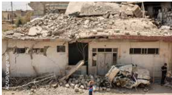
Casas gravemente dañadas en el barrio de Al-Resala al oeste de Mosul, Irak.
